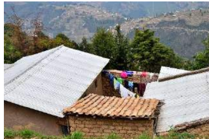
補修された屋根と洗濯物干場
